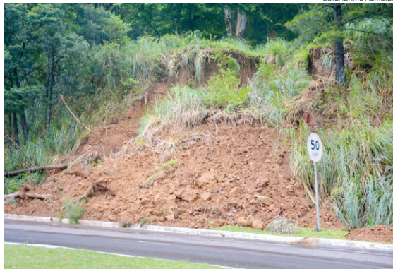
Encostas desmoronaram na entrada do bairro Três Pinheiros
